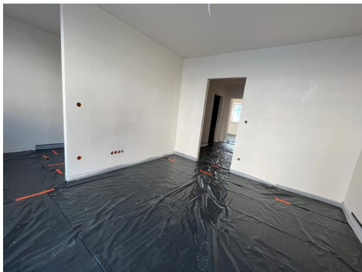
Budynek A1 – prace przygotowawcze do wykonania posadzek w lokalach
