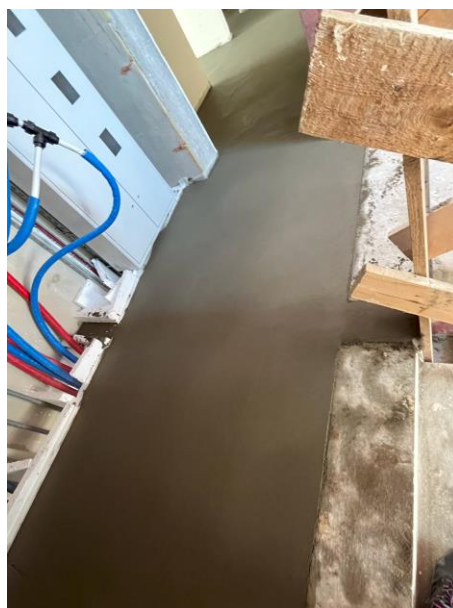
Budynek A1, klatka A2 – montaż posadzki na klatkach schodowych
