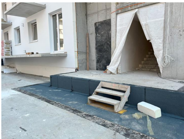
Budynek A1, klatka 2 – strefa wejścia, izolacje
