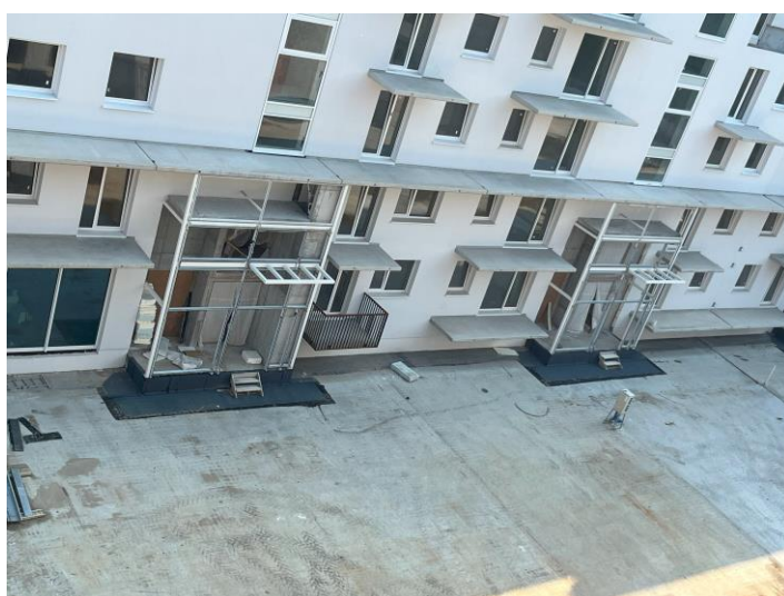
Widok budynek A2 – izolacja strefy cokołowej przy weściach do budynku
