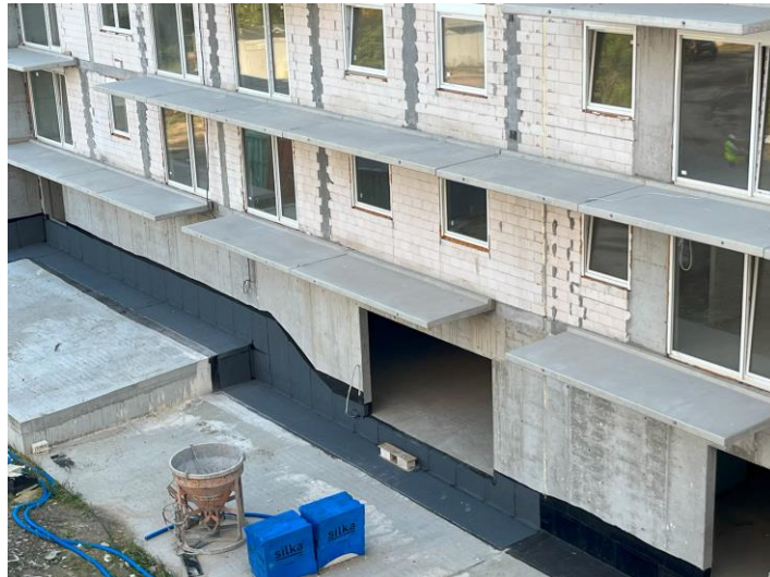
Widok na budynek B, strona zachodnia – montaż okien na IV piętrze i izolacja cokołowa
