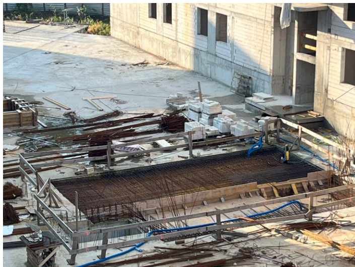
Patio pomiędzy budynkami C i D – trwają prace przy demontażu otworów po żurawiu
