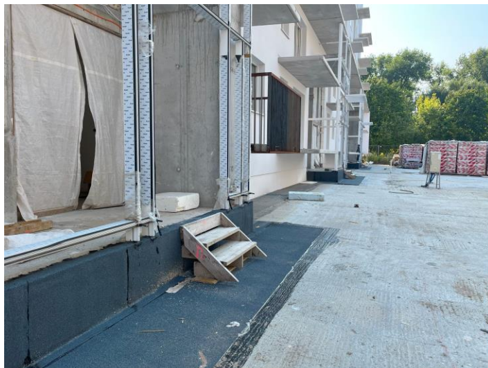
Widok budynek A2 – strefa wejść, izolacje
