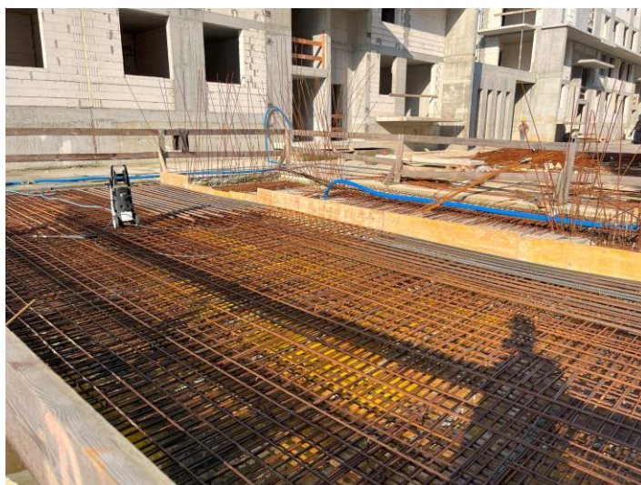
Patio pomiędzy budynkami C i D – trwają prace zbrojarskie
