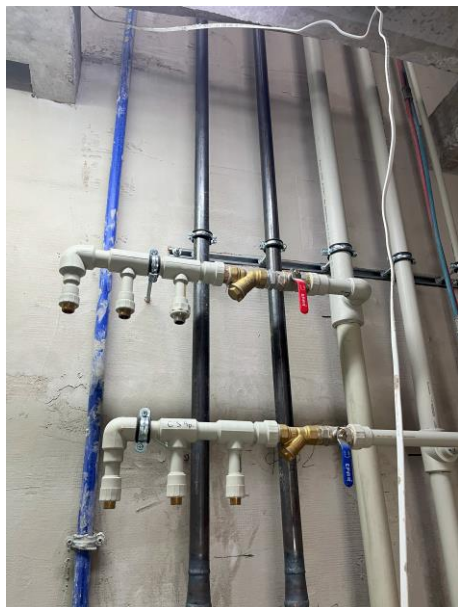
Budynek C – trwają prace przy montażu instalacji pionów na klatkach schodowych
