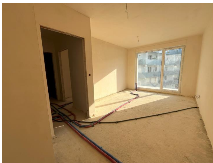
Budynek A1 – prace przy instalacjach podposadzkowych w lokalach
