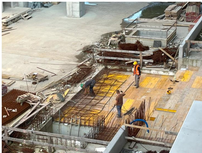
Patio przy budynku C – trwają prace przy demontażu otworów po żurawiu
