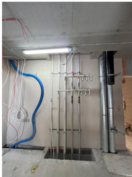
Budynek C – trwają prace przy montażu instalacji pionów na klatkach schodowych
