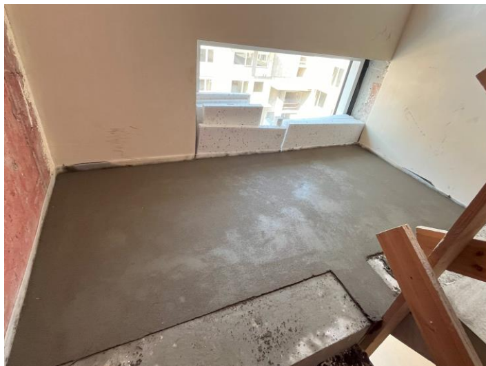
Budynek A1, klatka A2 – montaż posadzki na klatkach schodowych
