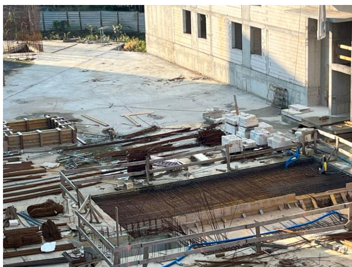
Patio pomiędzy budynkami C i D – trwają prace przy demontażu otworów po żurawiu
