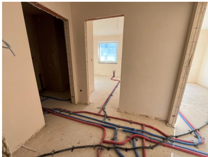
Budynek A1 – prace przy instalacjach podposadzkowych w lokalach
