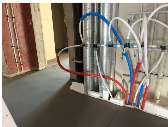
Budynek A1 – posadzki na klatkach schodowych
