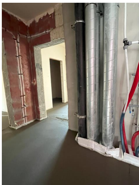
Budynek A1, klatka A2 – montaż posadzki na klatkach schodowych
