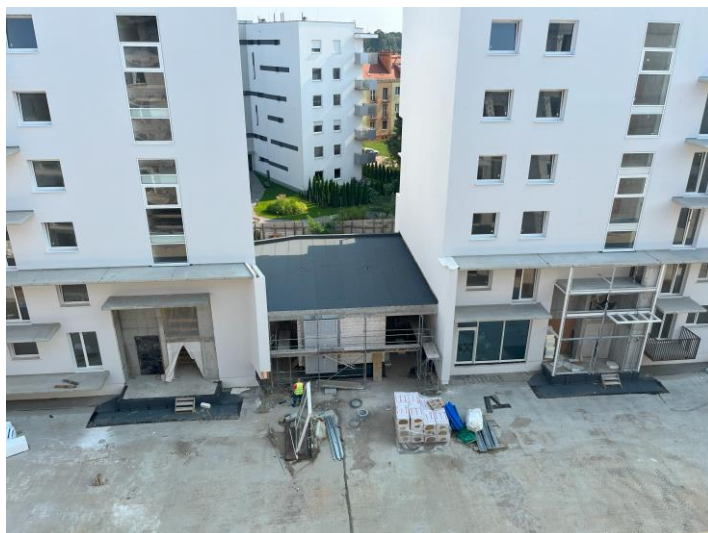
Budynek stacji trafo – izolacje i pokrycie dachu
