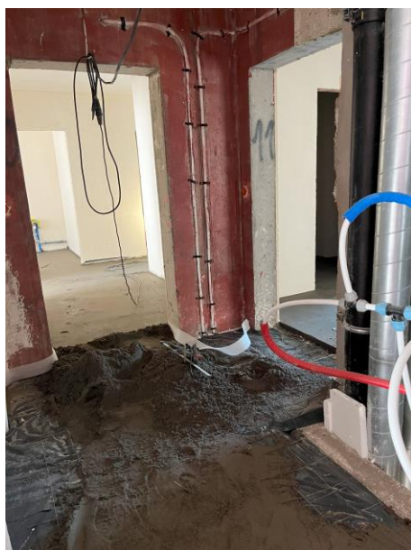
Budynek A1 klatka A2 – montaż posadzki
