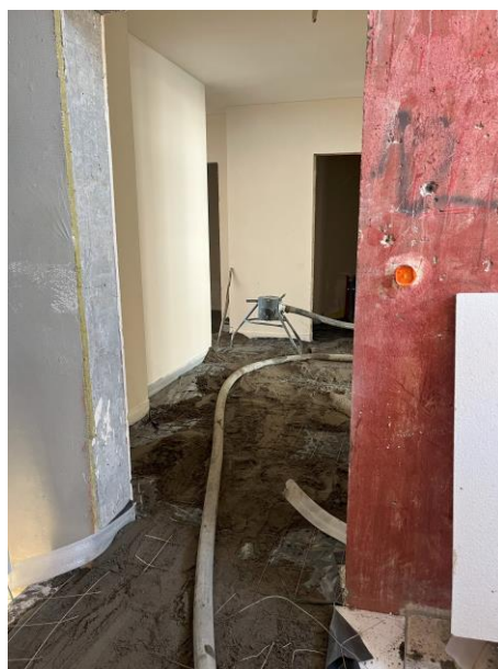
Budynek A1 klatka A2 – montaż posadzki
