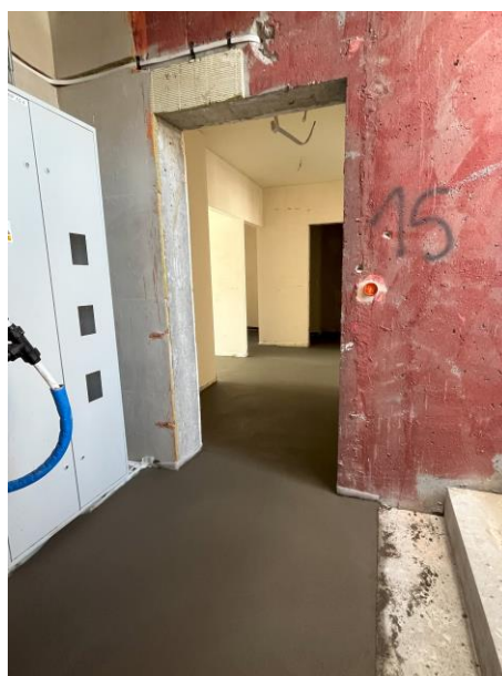
Budynek A1, klatka A2 – montaż posadzki na klatkach schodowych
