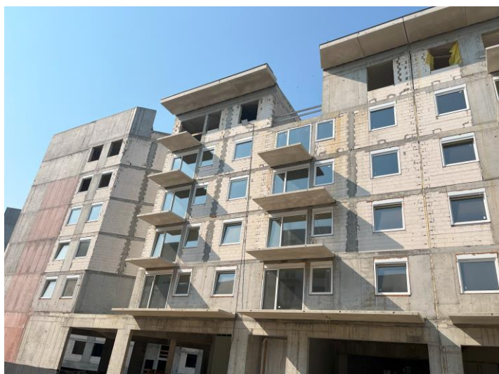
Widok budynku B – montaż stolarki okiennej na IV piętrze
