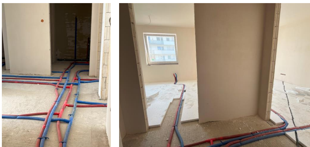
Budynek A1 klatka A2 – montaż instalacji podposadzkowej
