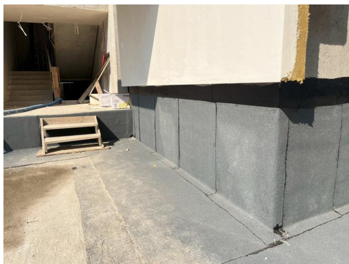
Widok budynek B, klatka B1 – izolacja strefy cokołowej
